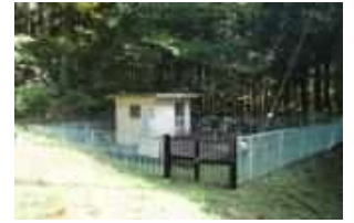
大平簡易水道配水池
