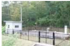
二岐専用水道配水池
