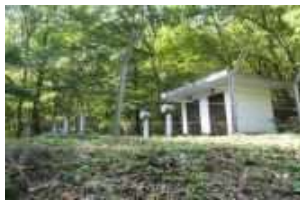
野仲簡易水道配水池
