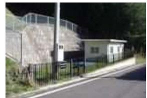
愛宕山配水池(第4配水池)
