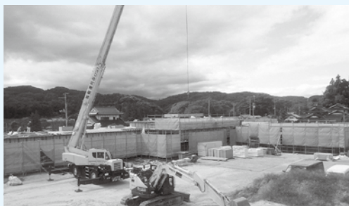
天栄保育所新築工事請負費 新しく保育所を移転 3億3,000万円
