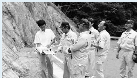
児渡安養寺線落石対策工事について確認
