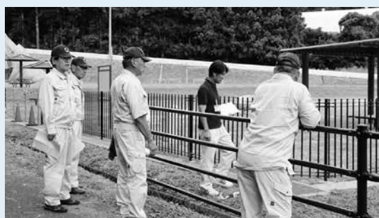
てんえいふるさと公園広場整備状況確認
