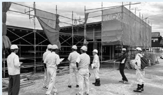
天栄保育所移転整備事業の進捗状況確認
