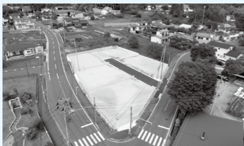
小規模住宅団地敷地造成工事費 新たな住宅団地分譲 3,634万円
